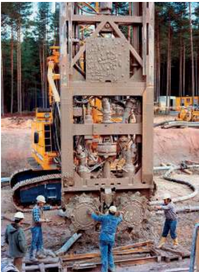
バウアーカッター1号機 1984年 BC 30 止水壁 @ブロムバッハ貯水池
